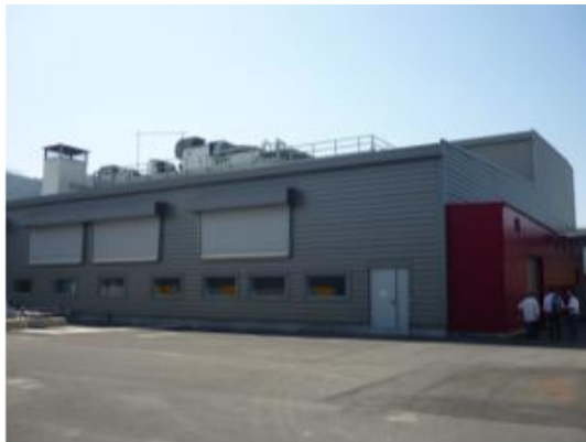
Figura 37: dettaglio esterno altri fabbricati
